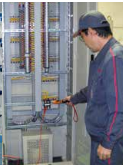
分電盤動作試験
