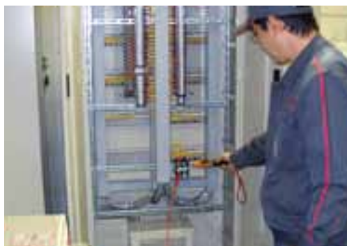
通信用分電盤耐圧検査
