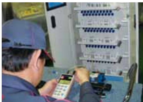
光配線盤光コード損失測定
