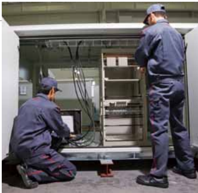
通信用シエルタ組立
