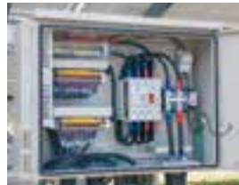
PV用SPD盤 (PV用接続箱)
