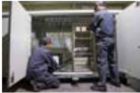
工事・システム導入
