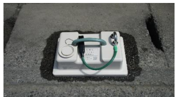
本体箱の設置
