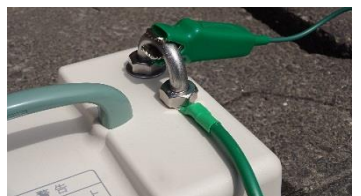
接地線の接続
