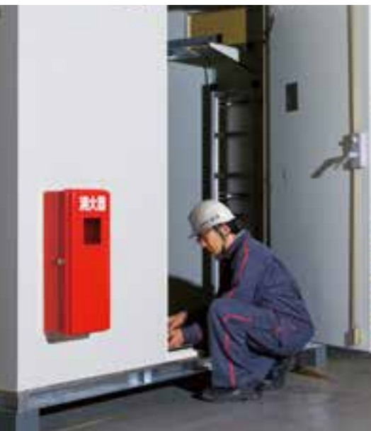
通信用シェルタ組立
