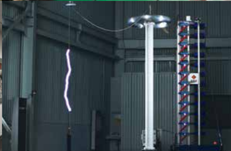
雷インパルス電圧発生装置
