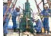
直撃雷対策 深埋設接地工法 (U・MF式、絶縁独立式) 雷電流を地中深部の別接地へ放出し、電位上昇を抑制 P45 ▶
