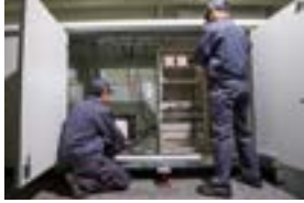
工事・システム導入
