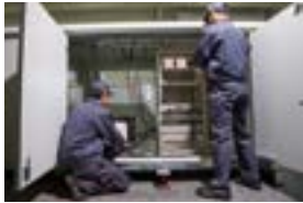
工事・システム導入
