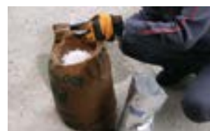
上端をカッターで切り開いて水カットを投入
